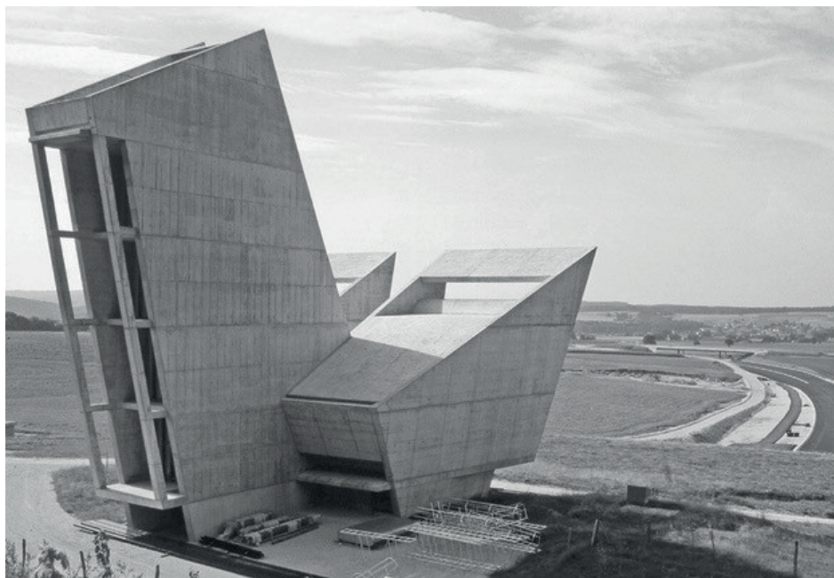
Lüftungszentrale A16, Flora Ruchat-Roncati
